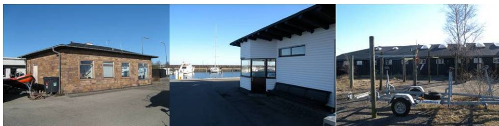
Figur 5-2 Billederne viser fra venstre mod højre havnekontoret, tankstation for både samt P. Nordbjærgets Bådeværft.
